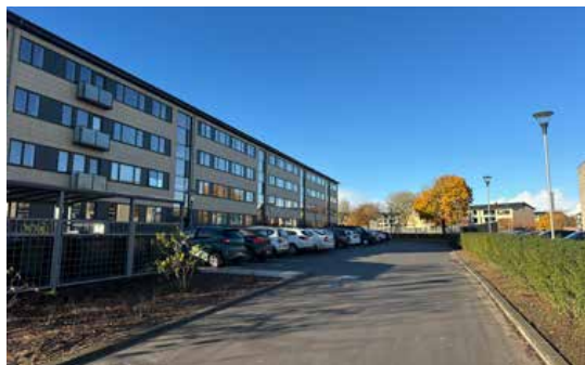
P-pladserne ved blok 1 og 8 på Lupinvej
